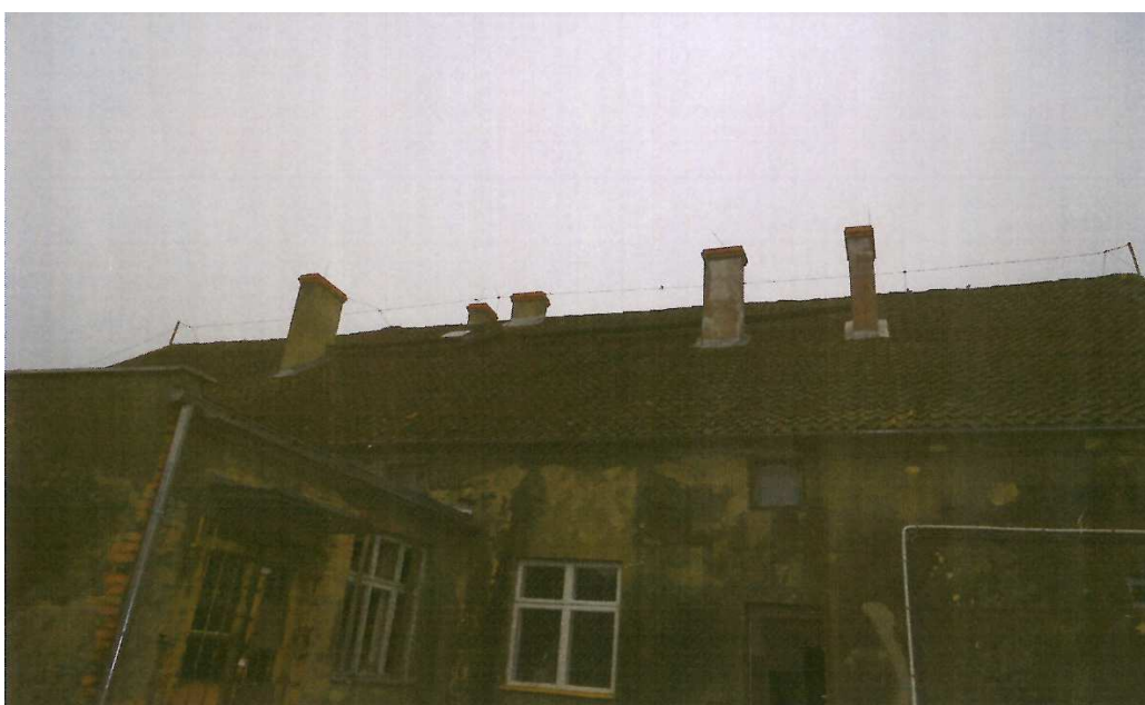
Fotografie obrazujące budynek Wspólnoty Mieszkaniowej Siedlisko 16
