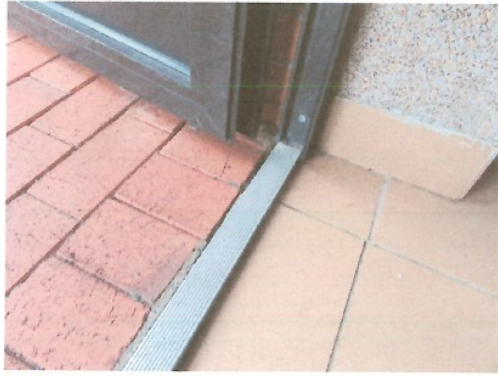
Luźne progi w drzwiach wejściowych
