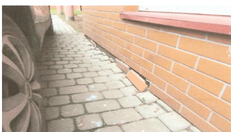
Uszkodzenia okładzin cokołu
