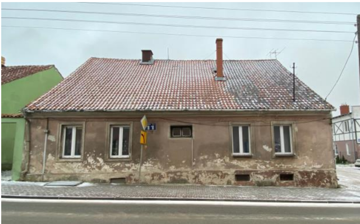
Fot.1. Gołdap, budynek mieszkalny ul. Mazurska 11 – elewacja frontowa, stan obecny. Fot. J.Baran.
