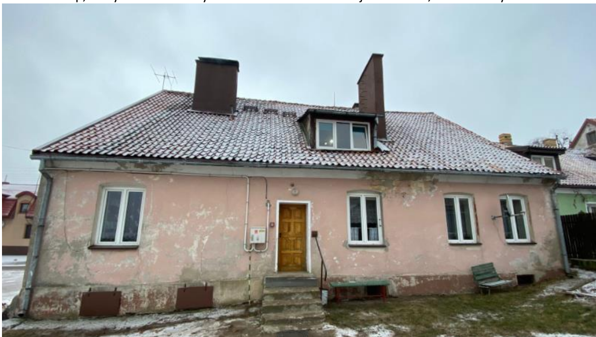
Fot.2. Gołdap, budynek mieszkalny ul. Mazurska 11 – elewacja tylna, stan obecny. Fot. J.Baran.
