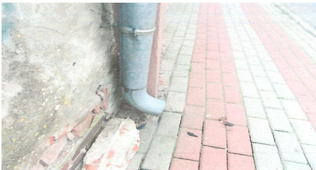
Fotografia obrazująca obecne odprowadzenie wody z wylewki.
