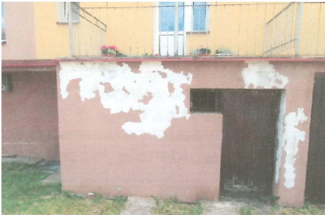
Fotografia obrazująca cokół budynku.
