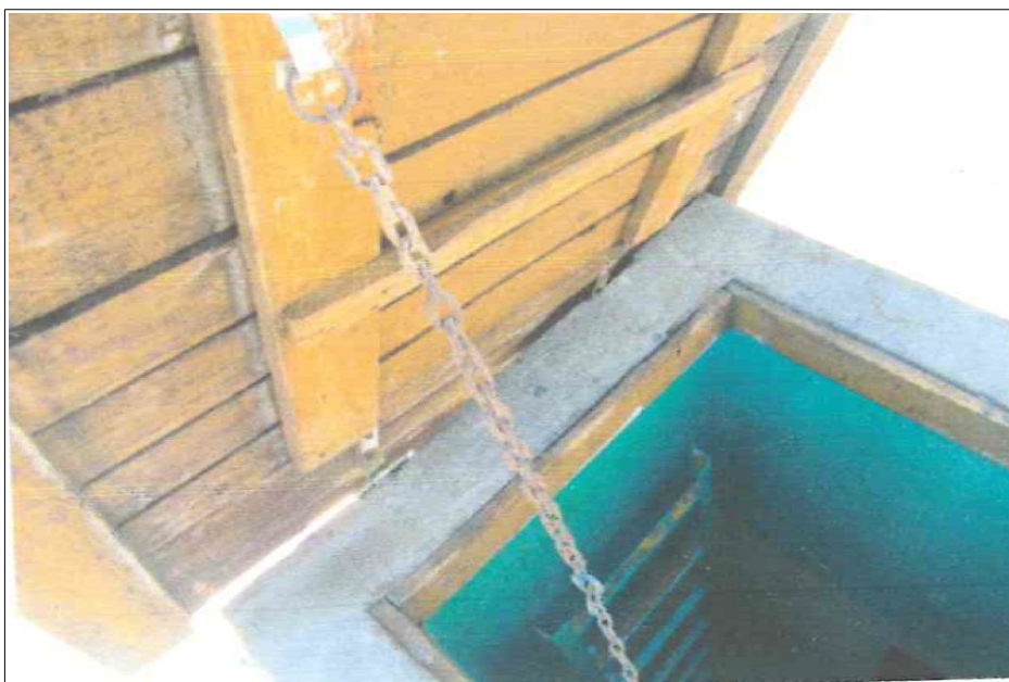
Fotografia obrazująca klapę w dachu.
