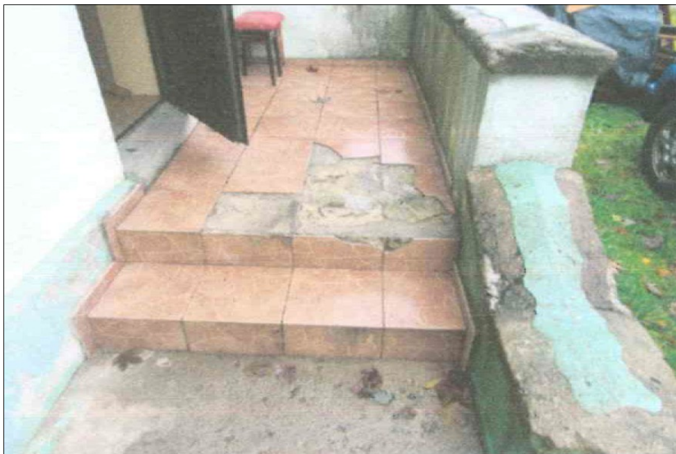
Fotografia obrazująca murek przed wejściem do budynku.
