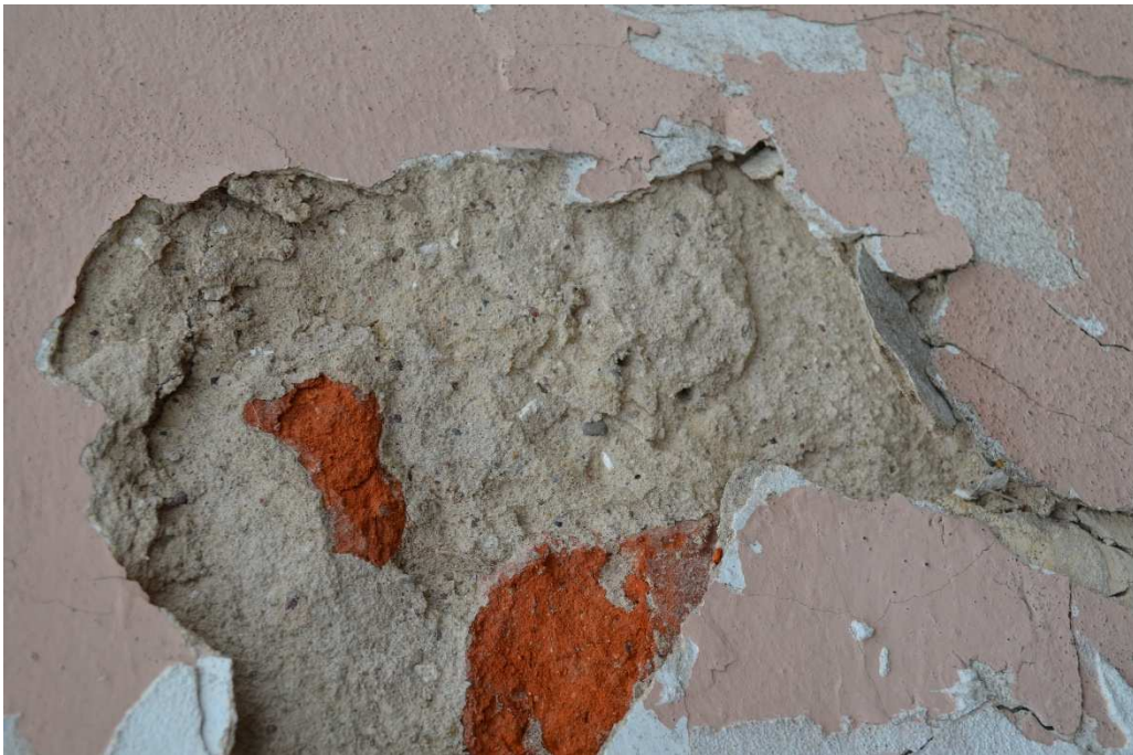
Fot.32. Gołdap- kamienica przy ul. Mazurskiej 11– elewacja boczna, zbliżenie- stan obecny. Fot. B. Kwasiborska
