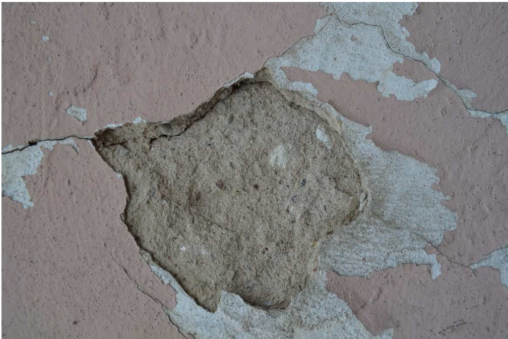
Fot.34. Gołdap- kamienica przy ul. Mazurskiej 11– elewacja boczna, zbliżenie- stan obecny. Fot. B. Kwasiborska
