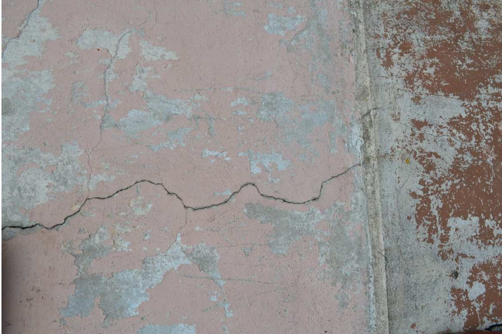
Fot.29. Gołdap- kamienica przy ul. Mazurskiej 11– elewacja tylna, zbliżenie- stan obecny. Fot. B. Kwasiborska
