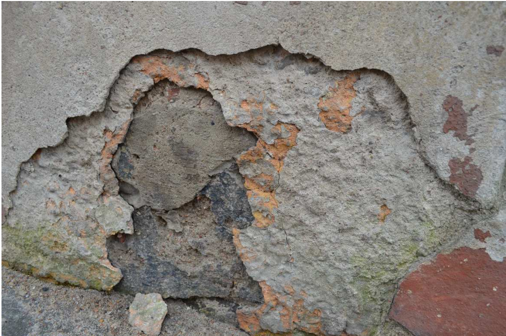
Fot.35. Gołdap- kamienica przy ul. Mazurskiej 11– elewacja boczna, zbliżenie- stan obecny. Fot. B. Kwasiborska
