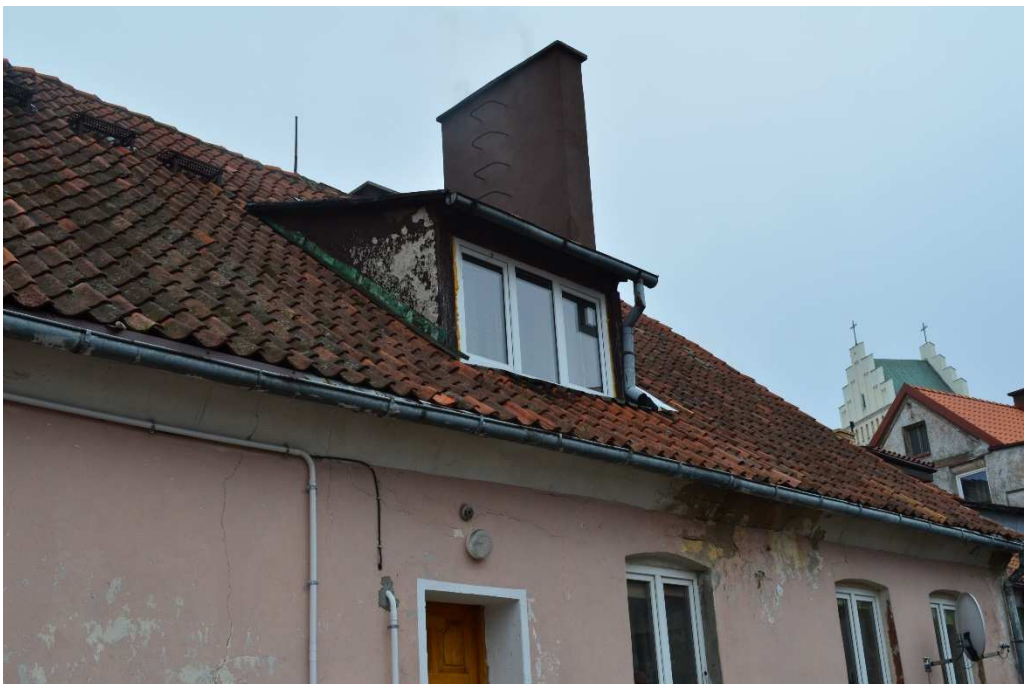
Fot.16. Gołdap- kamienica przy ul. Mazurskiej 11– elewacja tylna, zbliżenie- stan obecny. Fot. B. Kwasiborska
