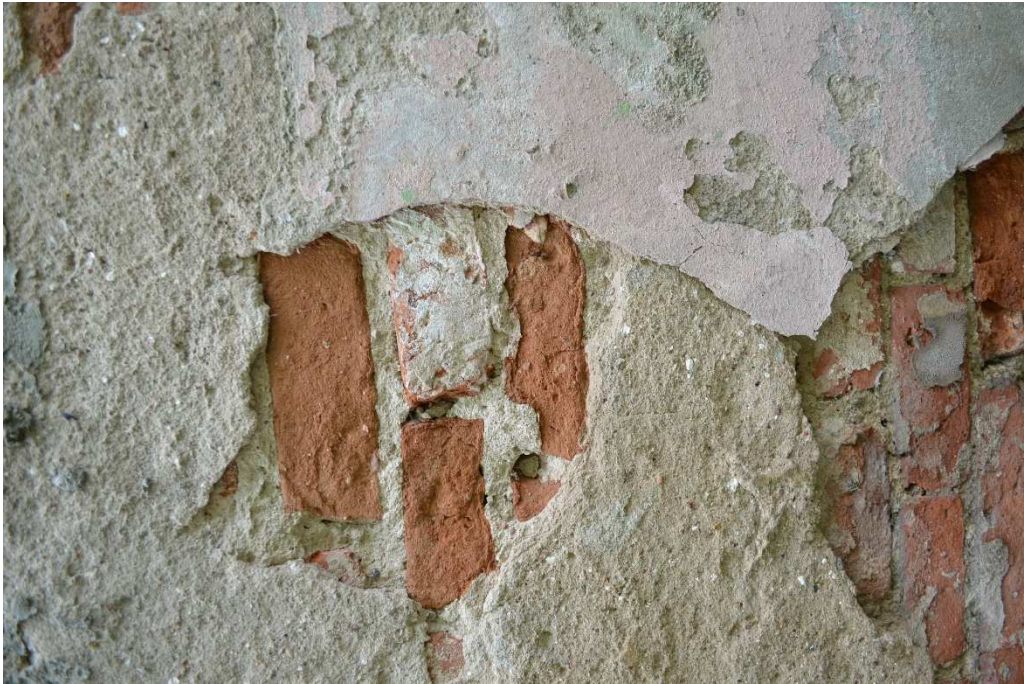
Fot.25. Gołdap- kamienica przy ul. Mazurskiej 11– elewacja boczna, zbliżenie- stan obecny. Fot. B. Kwasiborska
