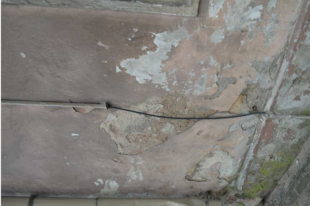
Fot.21. Gołdap- kamienica przy ul. Mazurskiej 11– elewacja boczna, zbliżenie- stan obecny. Fot. B. Kwasiborska
