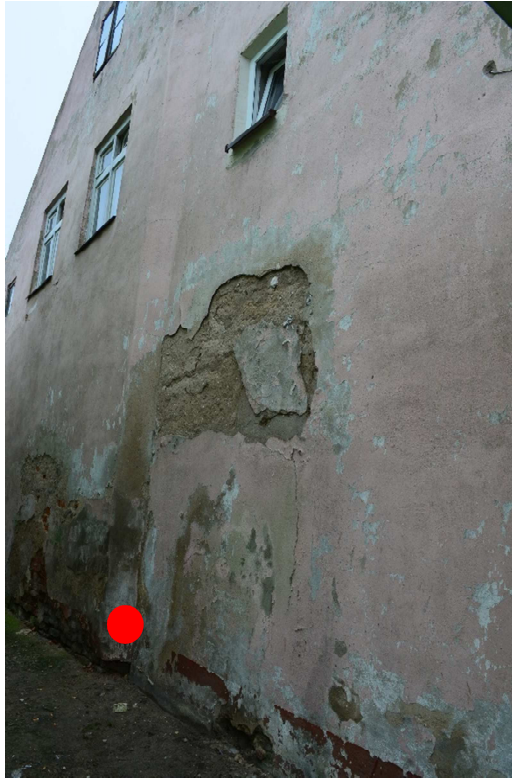
Fot.3. Gołdap- kamienica przy ul. Mazurskiej 11 elewacja boczna- miejsca pobrania próbek. Fot. B. Kwasiborska
