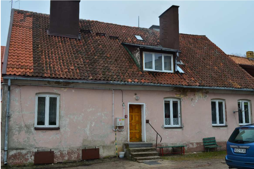
Fot.11. Gołdap- kamienica przy ul. Mazurskiej 11– elewacja tylna, widok ogólny- stan obecny. Fot. B. Kwasiborska
