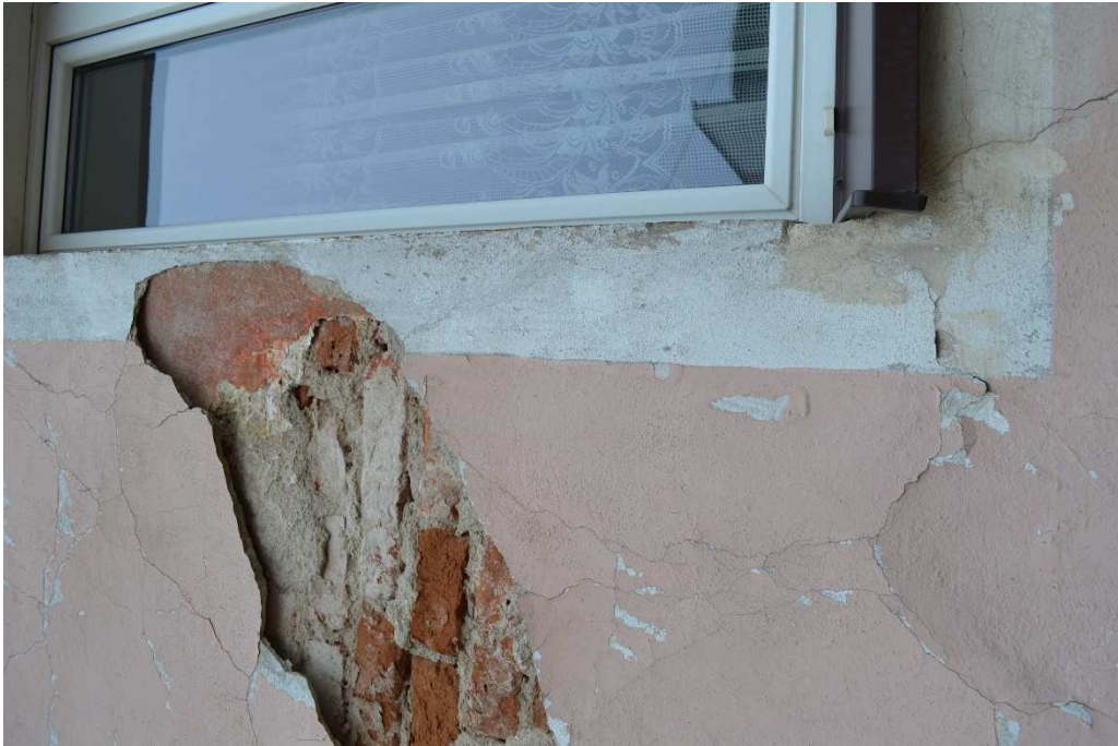
Fot.9. Gołdap- kamienica przy ul. Mazurskiej 11– elewacja boczna, zbliżenie- stan obecny. Fot. B. Kwasiborska
