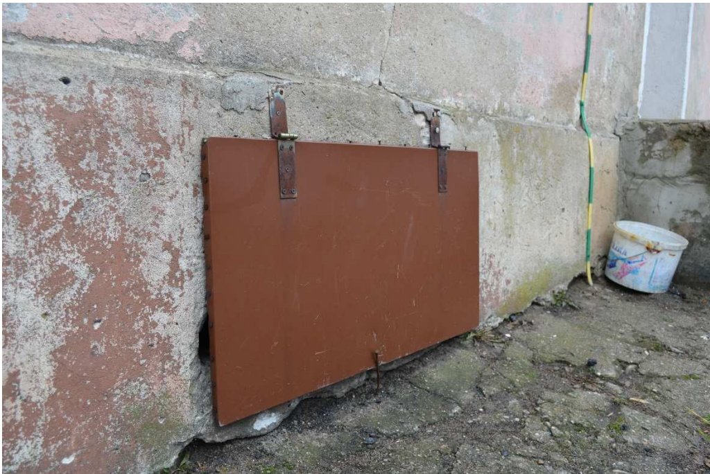
Fot.14. Gołdap- kamienica przy ul. Mazurskiej 11– elewacja tylna, zbliżenie- stan obecny. Fot. B. Kwasiborska
