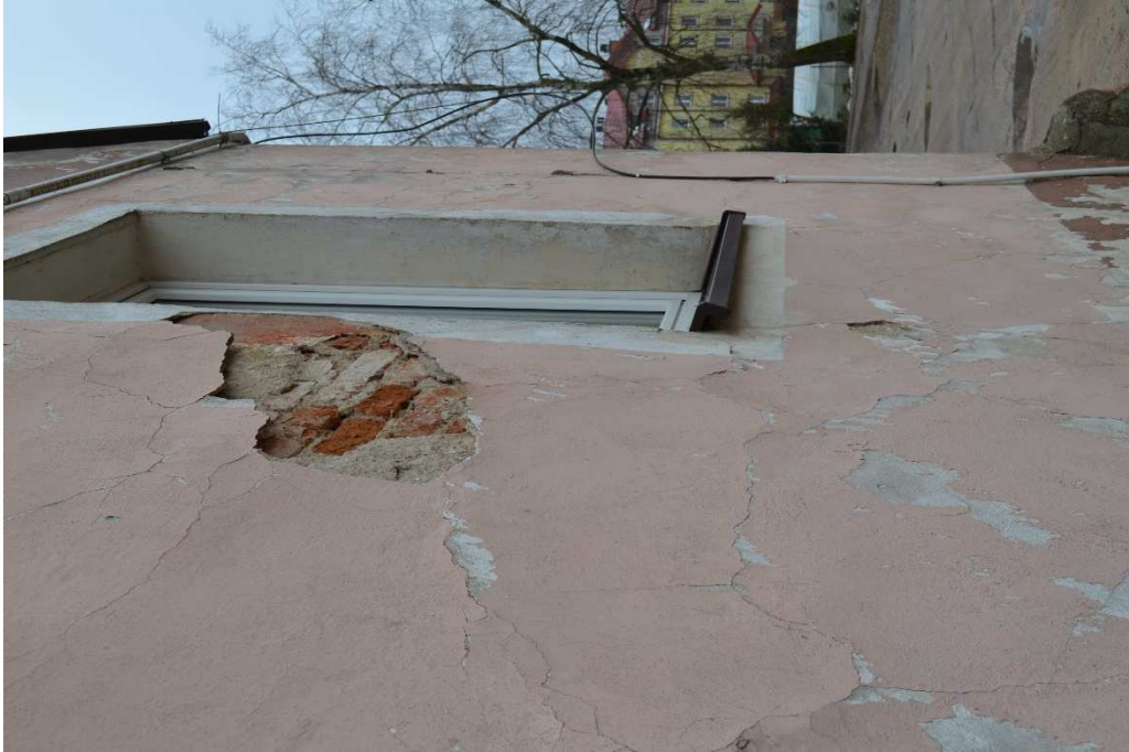
Fot.33. Gołdap- kamienica przy ul. Mazurskiej 11– elewacja boczna, zbliżenie- stan obecny. Fot. B. Kwasiborska
