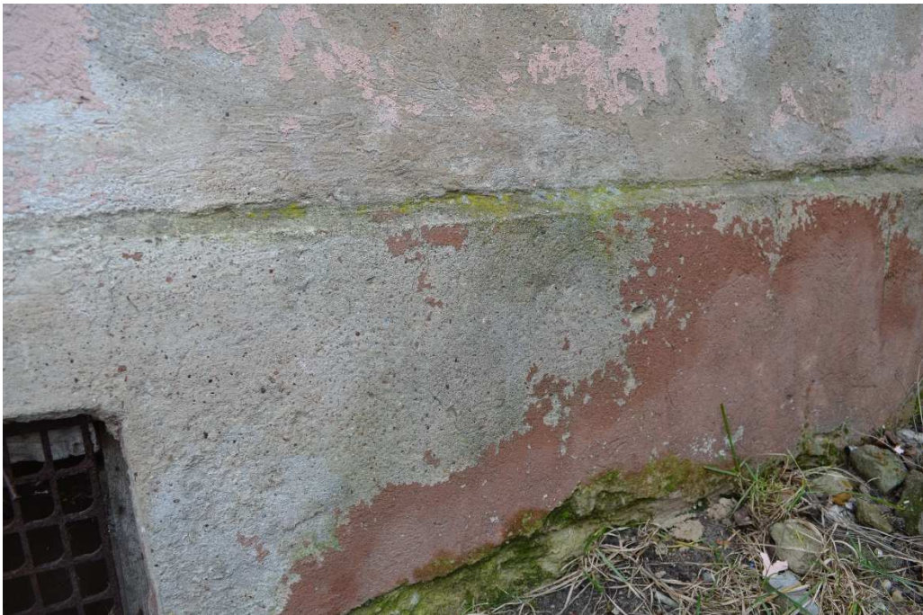
Fot.22. Gołdap- kamienica przy ul. Mazurskiej 11– elewacja tylna, zbliżenie- stan obecny. Fot. B. Kwasiborska
