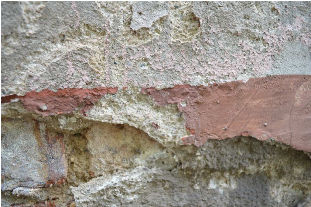
Fot.28. Gołdap- kamienica przy ul. Mazurskiej 11– elewacja boczna, zbliżenie- stan obecny. Fot. B. Kwasiborska
