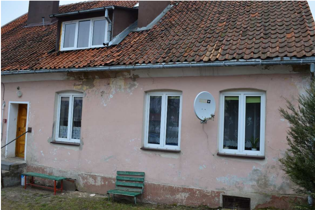
Fot.5. Gołdap- kamienica przy ul. Mazurskiej 11– elewacja tylna, widok ogólny- stan obecny. Fot. B. Kwasiborska
