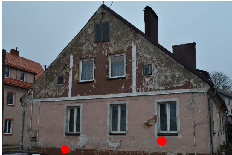
Fot.1. Gołdap- kamienica przy ul. Mazurskiej 11 elewacja boczna- miejsca pobrania próbek. Fot. B. Kwasiborska
