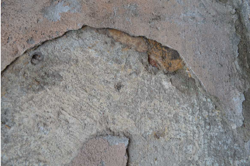
Fot.27. Gołdap- kamienica przy ul. Mazurskiej 11– elewacja boczna, zbliżenie- stan obecny. Fot. B. Kwasiborska
