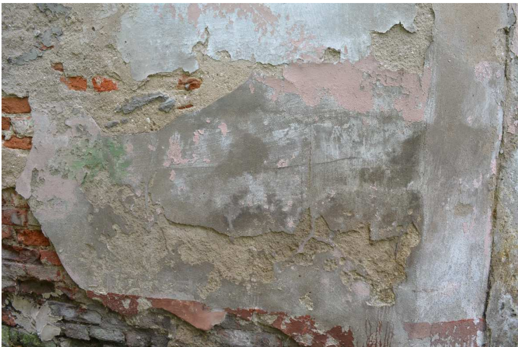
Fot.18. Gołdap- kamienica przy ul. Mazurskiej 11– elewacja boczna, zbliżenie- stan obecny. Fot. B. Kwasiborska
