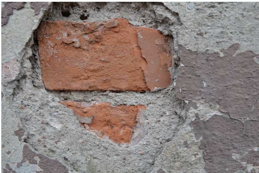
Fot.23. Gołdap- kamienica przy ul. Mazurskiej 11– elewacja boczna, zbliżenie- stan obecny. Fot. B. Kwasiborska
