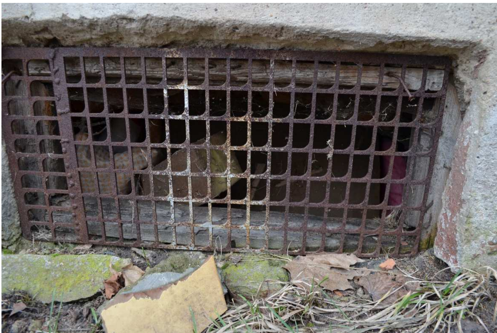
Fot.26. Gołdap- kamienica przy ul. Mazurskiej 11– elewacja tylna, zbliżenie- stan obecny. Fot. B. Kwasiborska
