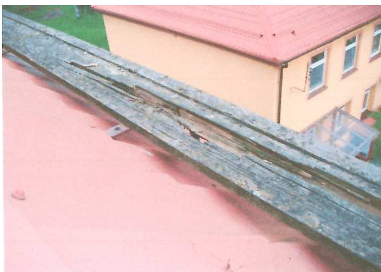
Fotografia obrazująca obecną ławę kominiarską na budynku Kościuszki 4 w Gołdapi
