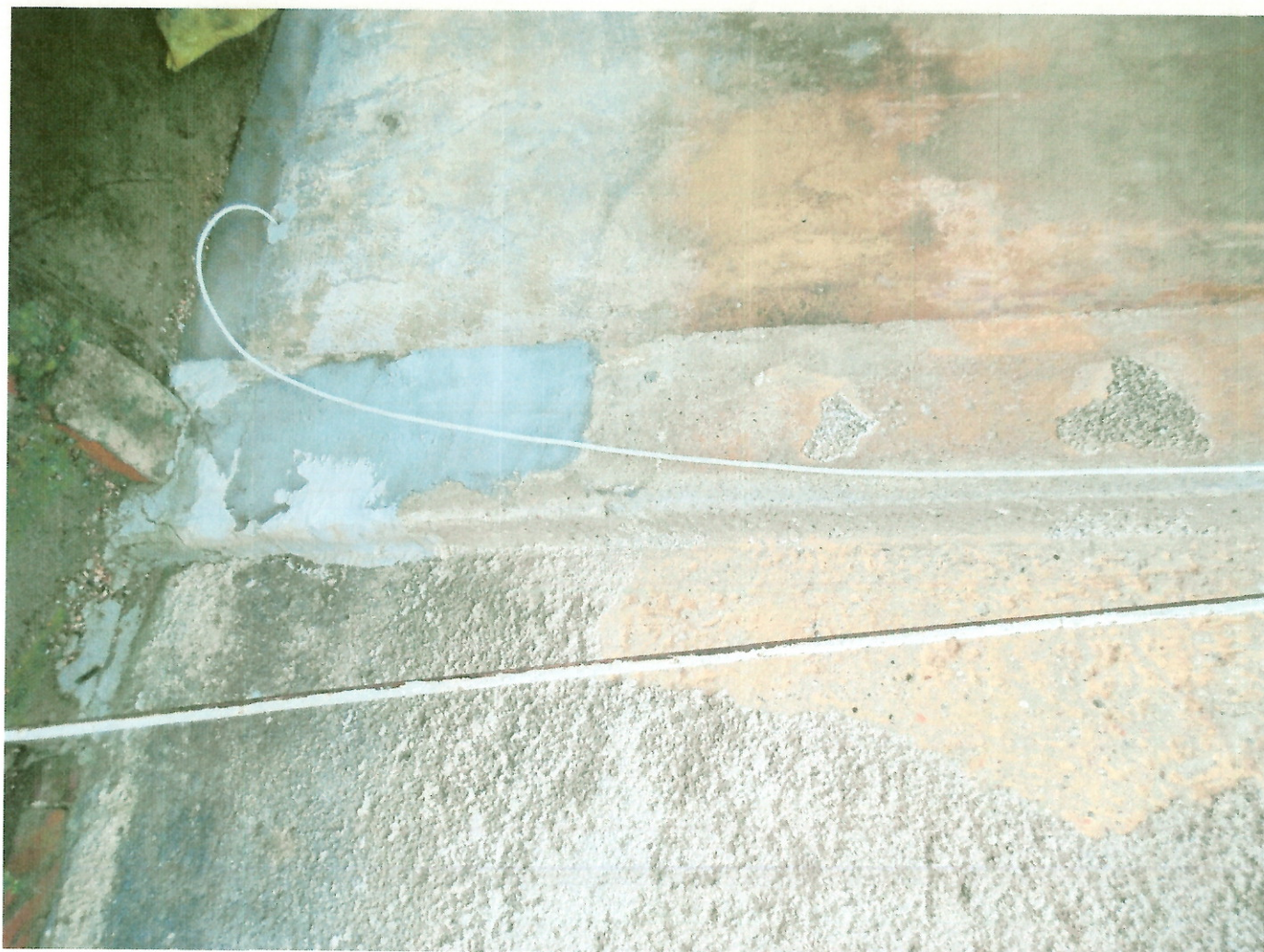
23. Otynkowany filar w ścianie budynku, w miejscu wyburzonego połączenia filaru z murkiem werandy.
