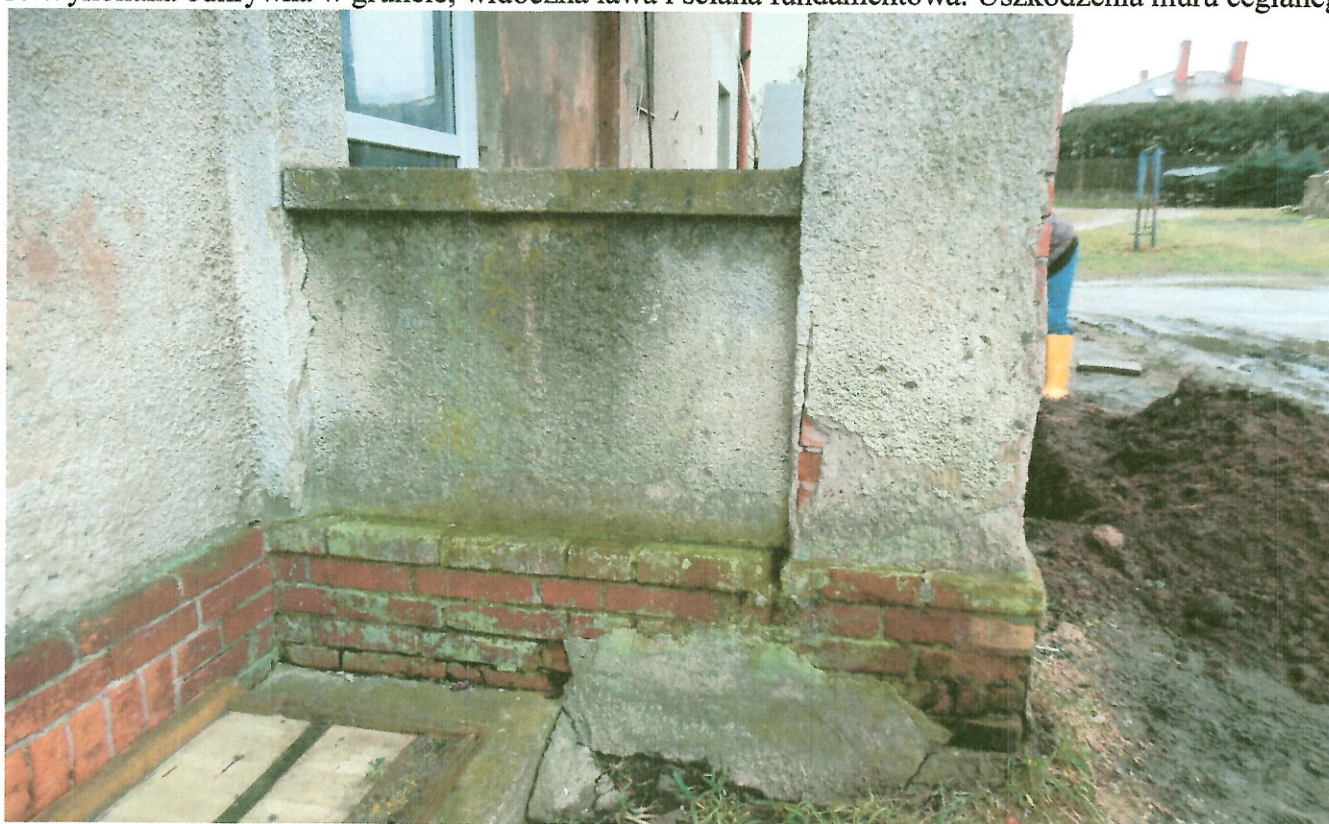
4. Widoczny murek osłonowy werandy i filar od strony północnej.
