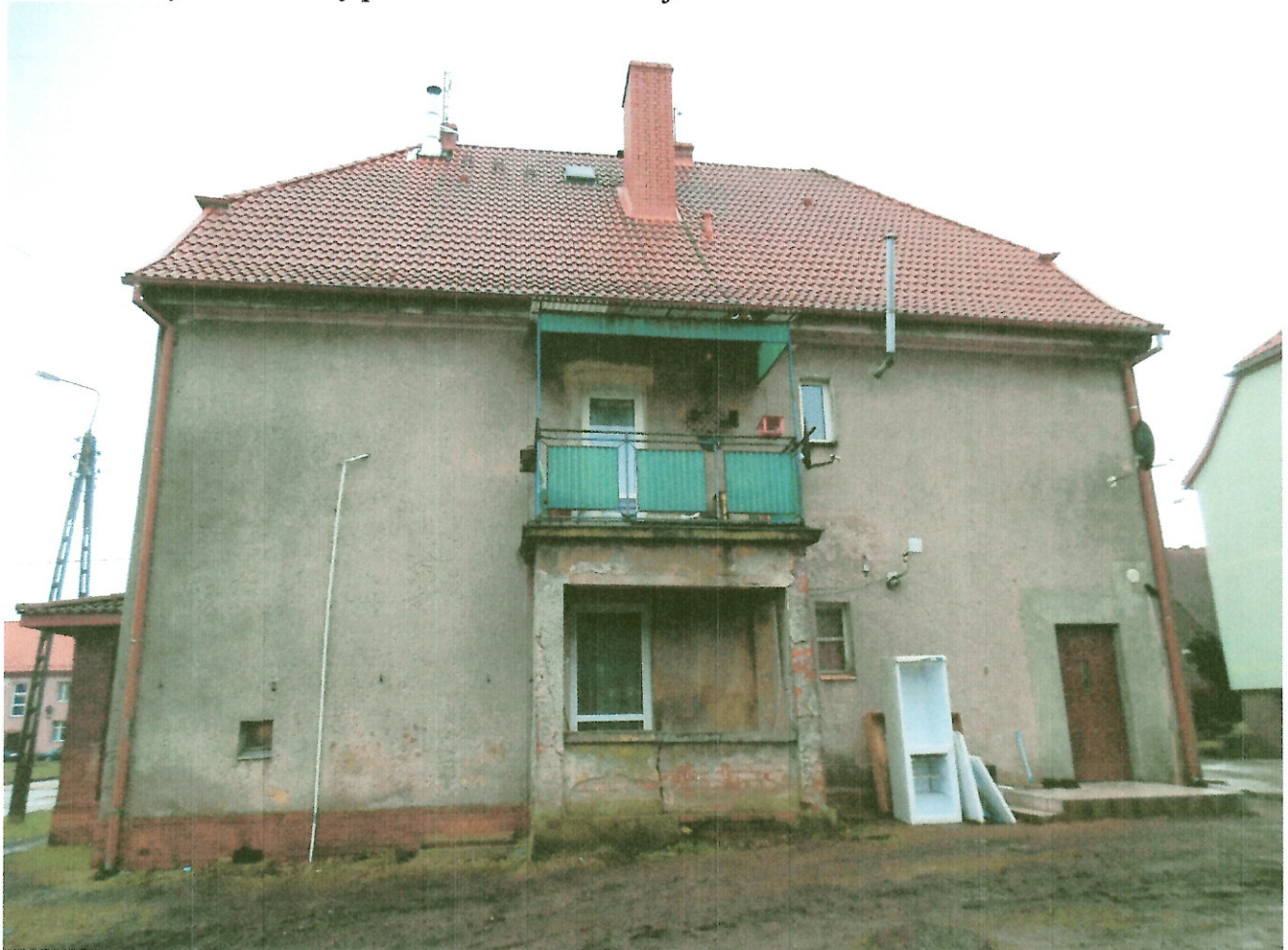
2. Elewacja budynku od strony zachodniej, od strony podwórka.
