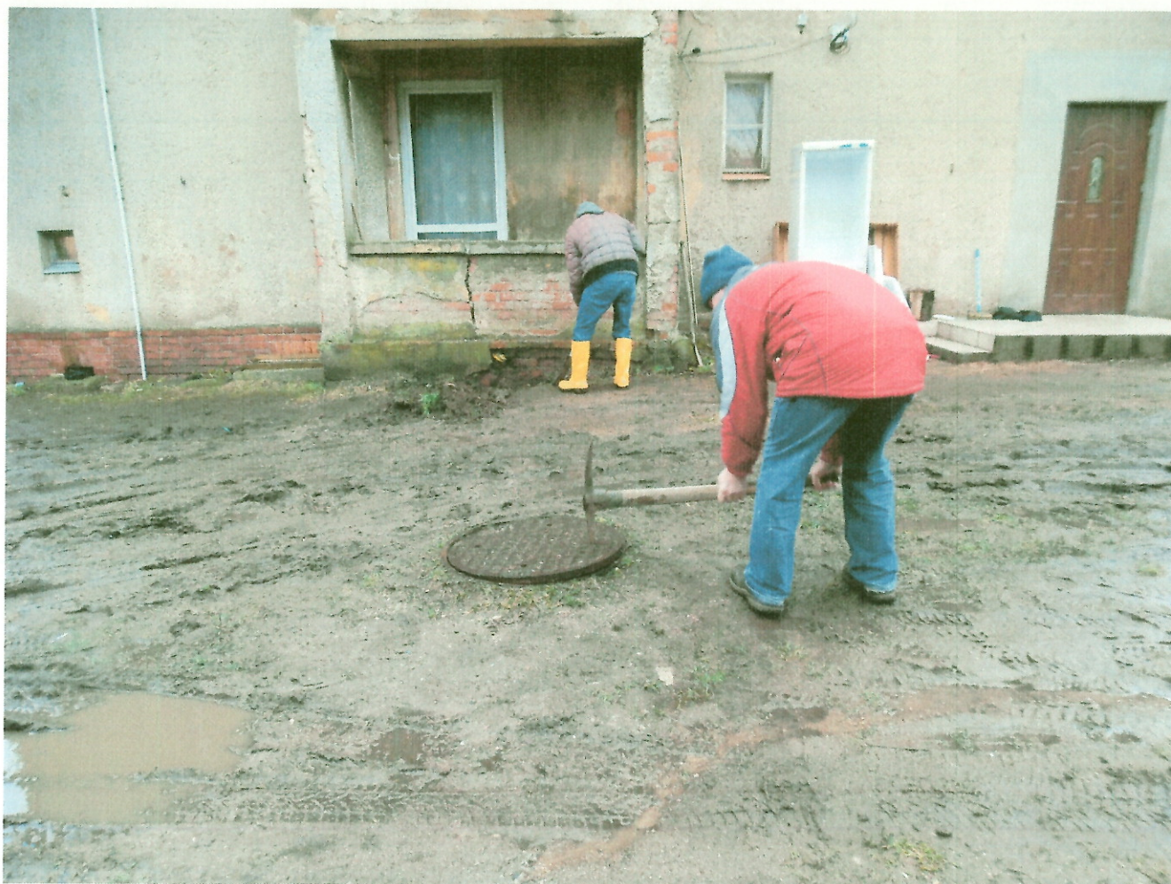
7. Wykonywanie odkrywek podczas oględzin w dniu 05.01.2018 r.
