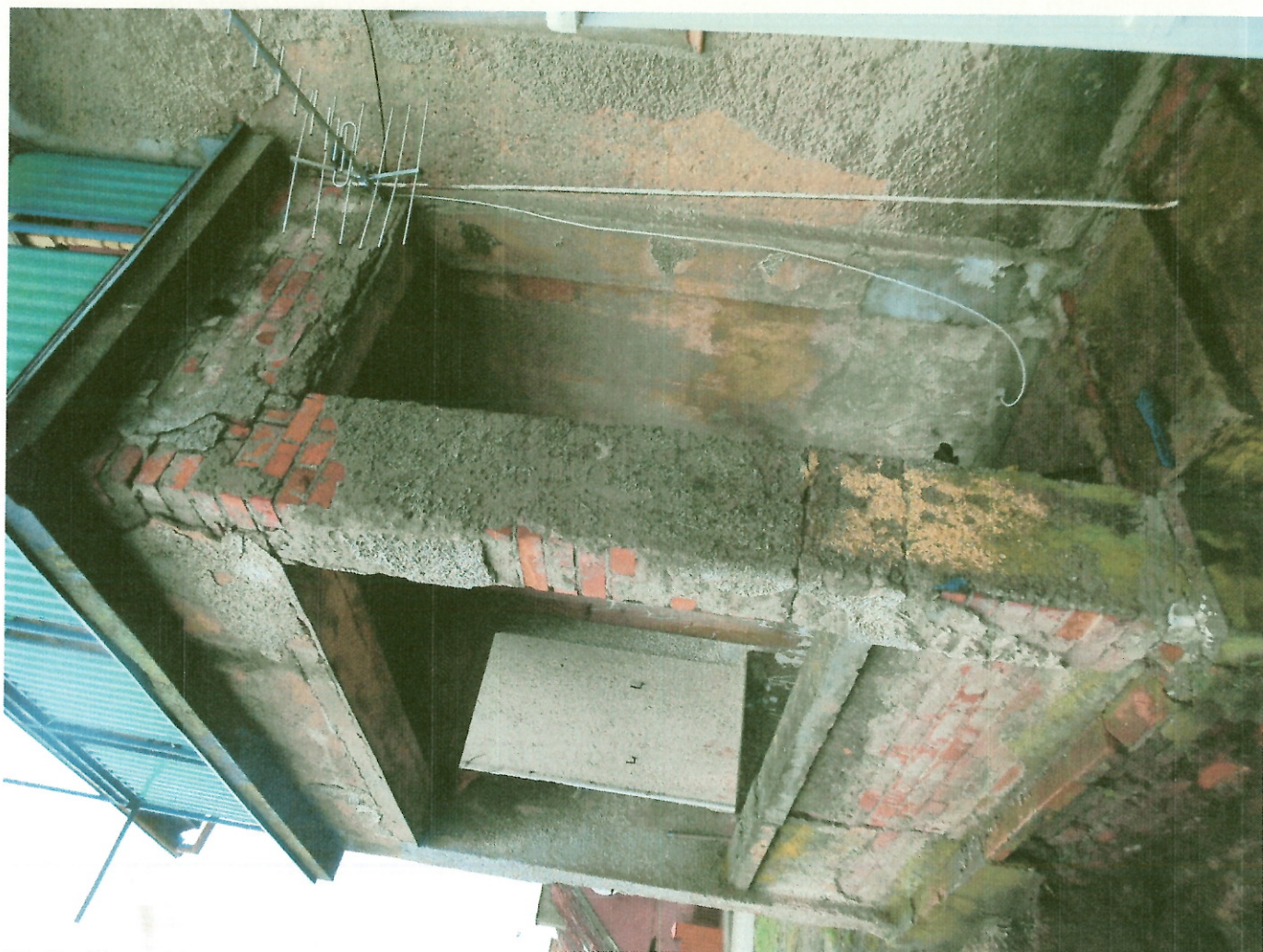
17. Ogólny widok na werandę od strony wykonanego wejścia od strony podwórka.
