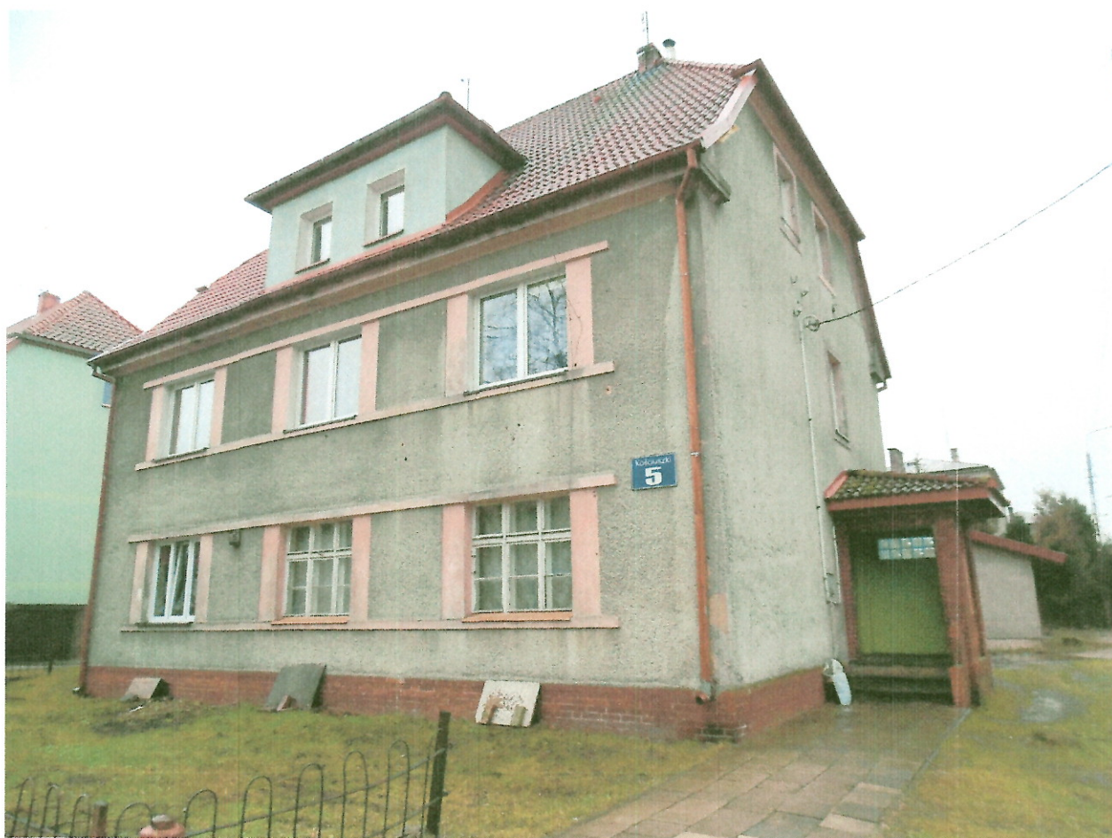
Widok budynku od strony ulicy Kościuszki. Widoczny wiatrołap przy głównym wejściu do budynku.
