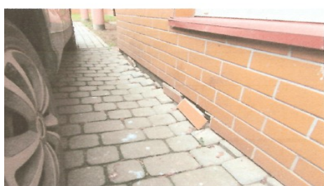
Uszkodzenia okładzin cokołu
