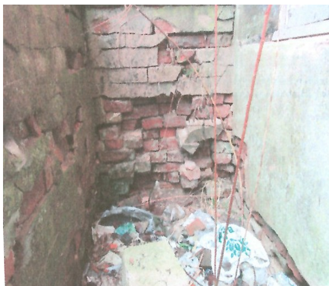
Fotografia obrazująca ściany zewnętrzne wejściowe do piwnic od strony podwórza.
