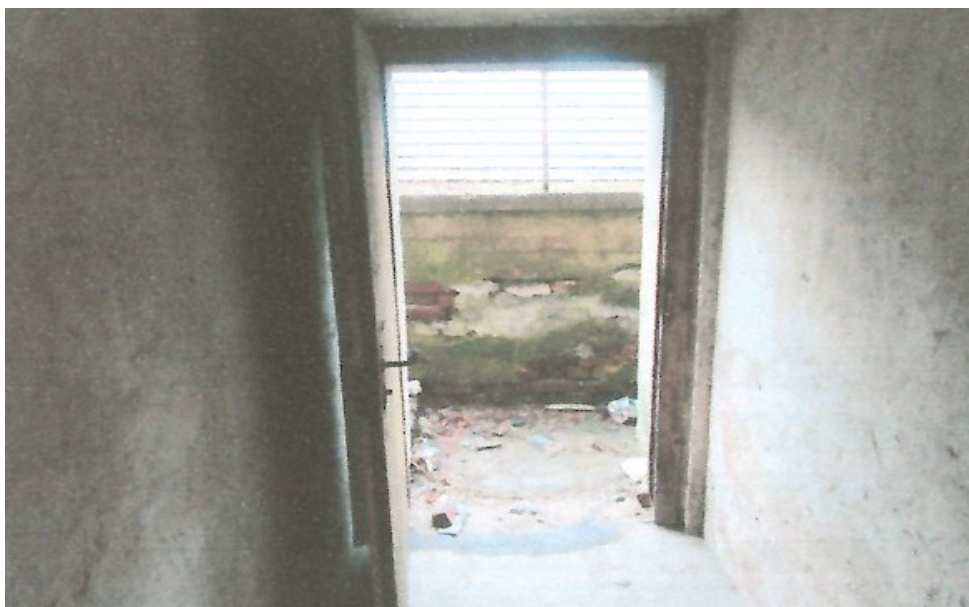
Fotografia obrazująca drzwi zewnętrzne do piwnic od strony podwórza.
