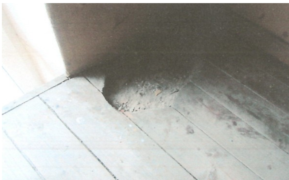
Fotografia obrazująca podeście schodów lewej klatki schodowej
