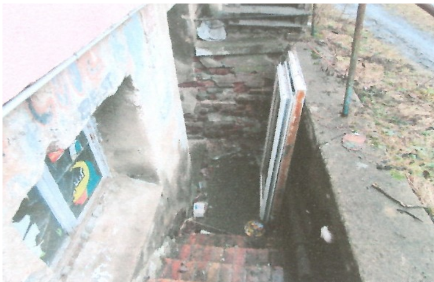
Fotografia obrazująca częściowo schody zejściowe do piwnic od strony podwórza.
