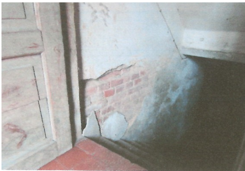
Fotografia obrazująca ścianę wewnętrzną do piwnicy w lewej klatce.
