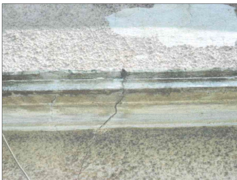
Fotografie obrazujące gzyms budynku WM Górna 20 w Gołdapi.
