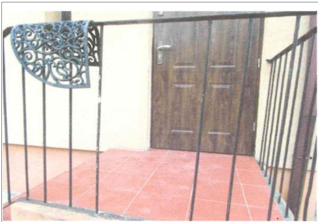
Fotografia obrazująca balustradę schodów zewnętrznych do mieszkania na parterze.
