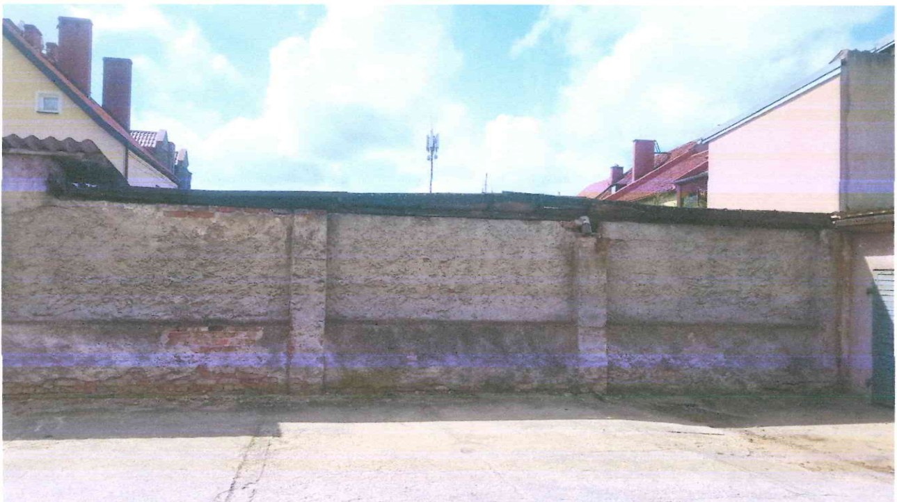
FOT. F-2. ELEWACJA TYLNA (WSCHODNIA)
