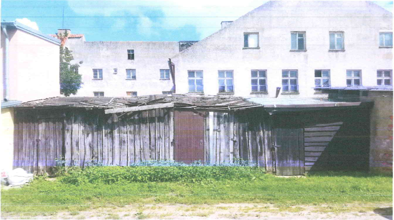
FOT. F-1. ELEWACJA FRONTOWA (ZACHODNIA)
